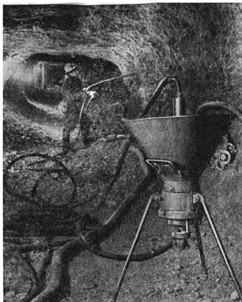
Рис. 32. Заряжание шнуров в лаве порционным зарядчиком ЗППН-3-II, оборудованным автоматически включающимся вибратором
